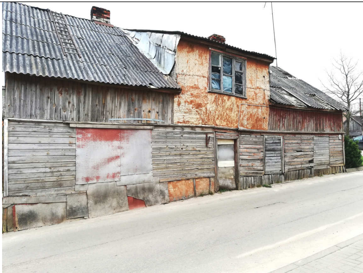
Nr. 2 Pavadinimas Pastato P.Cvirkos g. 8 vakarų fasadas (gatvės) Fotografavo Inga Jablonskė Data 2019-11-26
