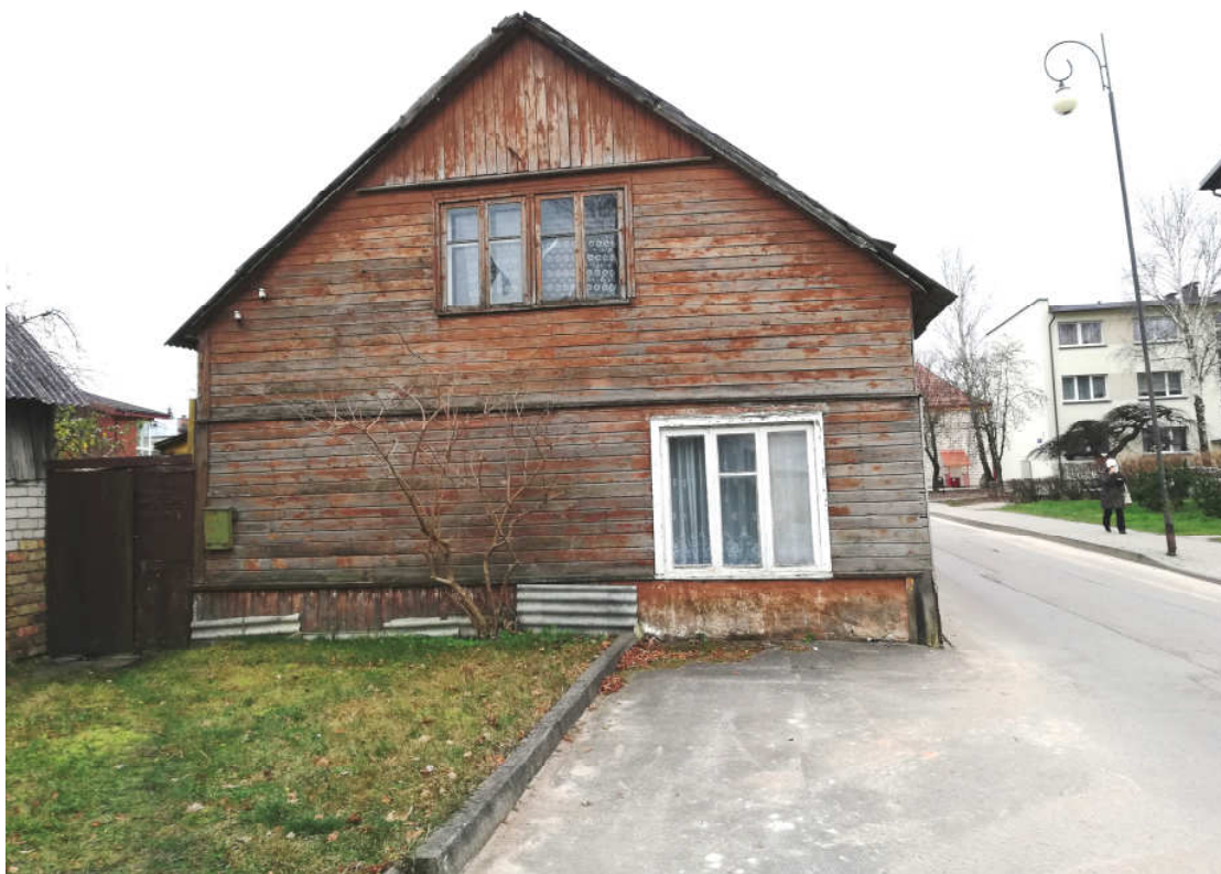
Nr. 1 Pavadinimas Pastato P.Cvirkos g. 8 šiaurės fasadas Fotografavo Inga Jablonskė Data 2019-11-26
